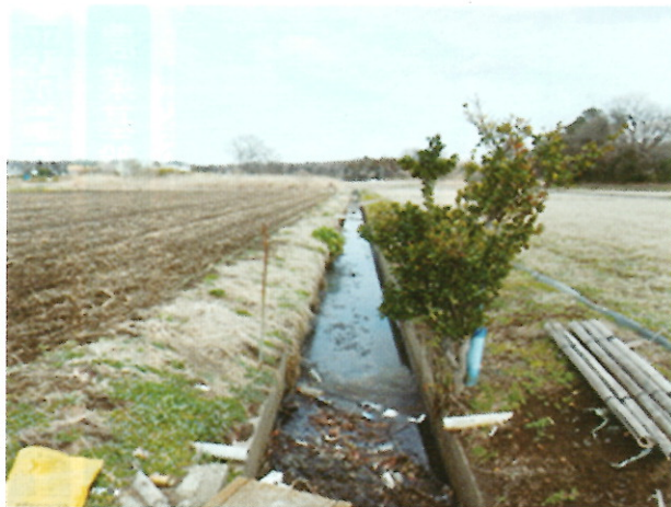
下妻市(江地内)の幹線排水路
