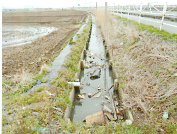
常総市(旧石下地内)の県道沿い排水路
