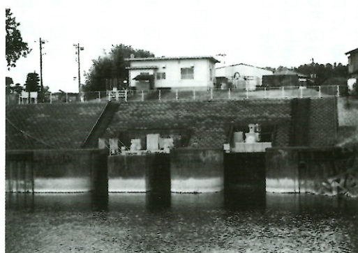
筑西市船玉地先鬼怒川に設置の「船玉揚水機場」 船玉第1 Φ600mm 180kw 2基 揚水量1.5t/min 船玉第2 Φ1000mm 420kw 1基 揚水量2.0t/min
