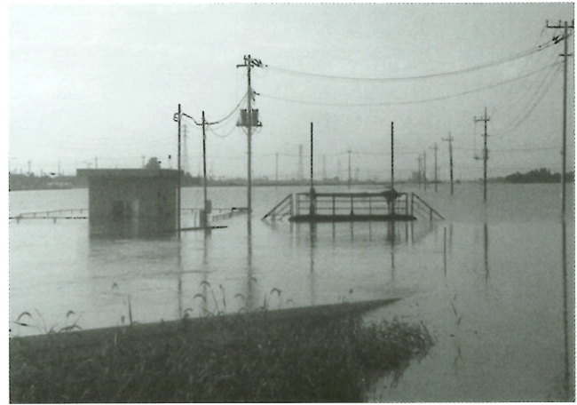
常総市 中山第3揚水機場付近 (水没)
