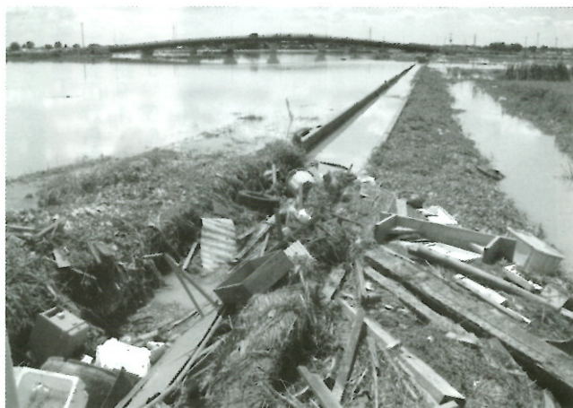
常総市石下支線用水路（ゴミ・土砂流入）
