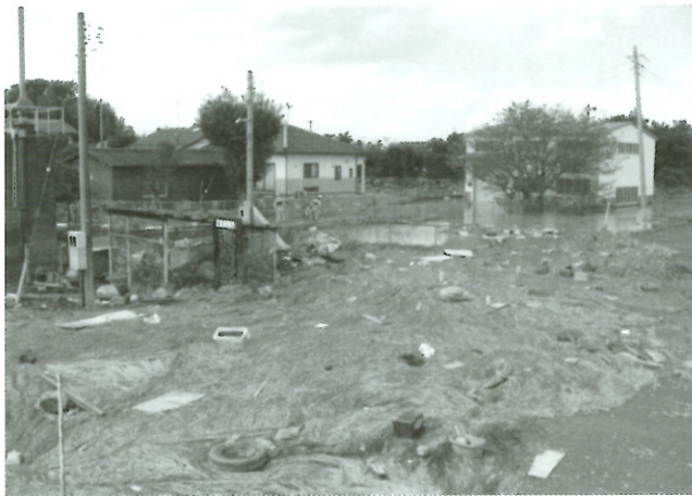
常総市 大生排水樋管周辺 (切藁・ゴミ流入)
