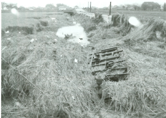
常総市石下東部地区排水路（切藁・ゴミ流入）
