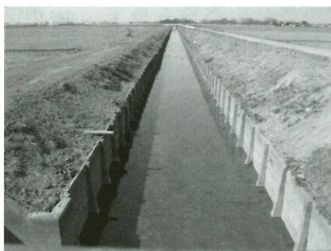
県営圃場整備にて造成された百間堀は、経年により法面土の流出が進行したため改修する。
